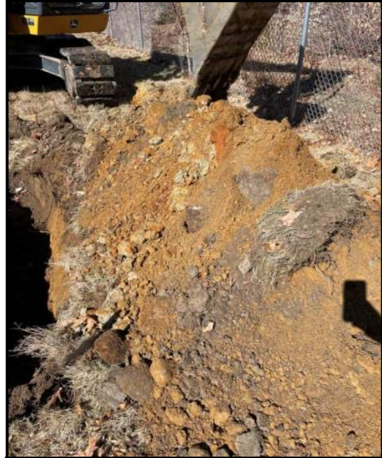
TP-115 spoils pile
