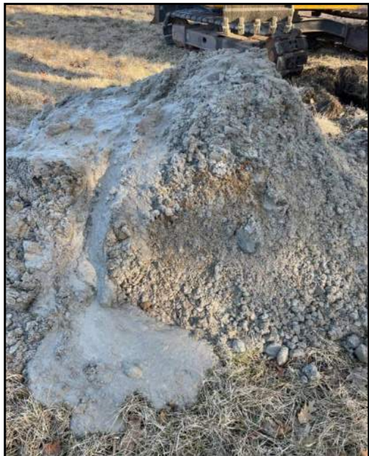
TP-107 spoils pile
