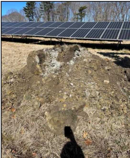
TP-116 spoils pile
