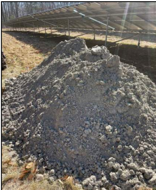
TP-114 spoils pile
