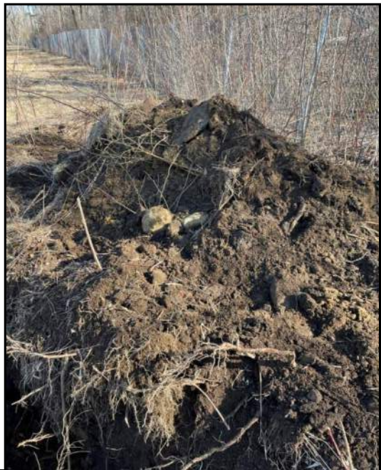
TP-111 spoils pile
