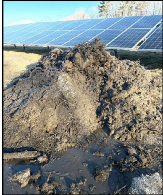
TP-106 spoils pile
