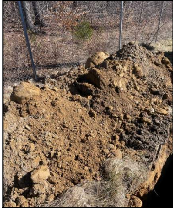
TP-114 spoils pile
