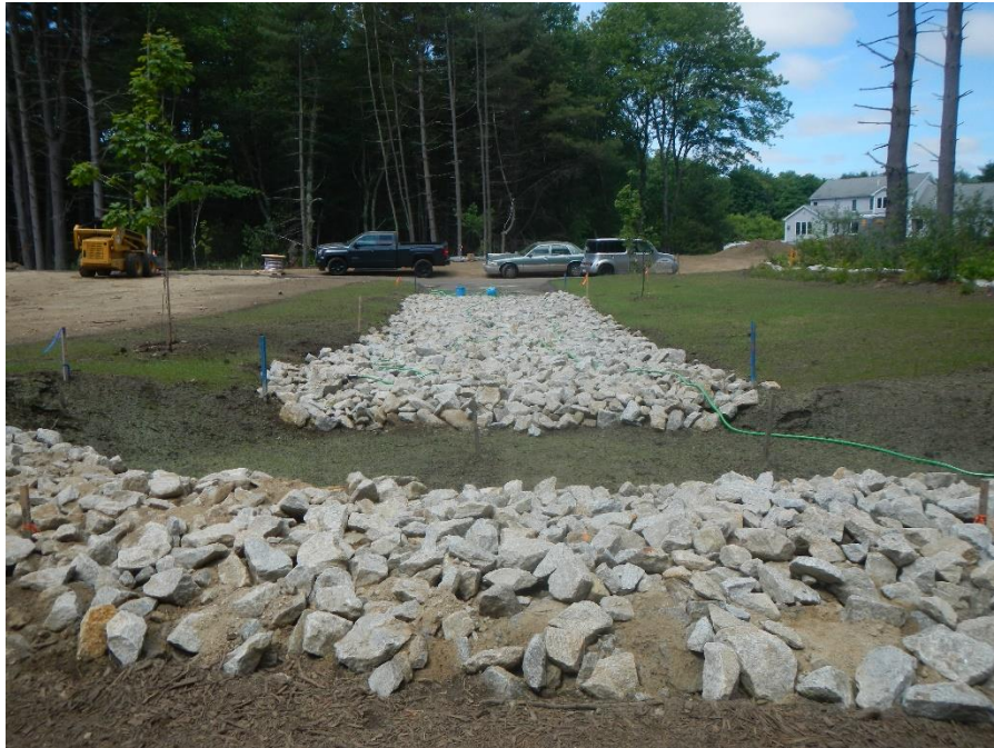
Rip rap and sediment forebay
