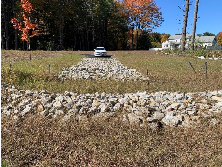
Rip rap and sediment forebay
